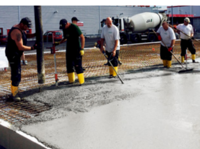
betonieren und verdichten
