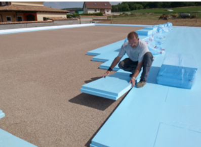
XPS-Wärmedämmung einbauen
