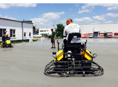
Oberfläche glätten ... fertig!
